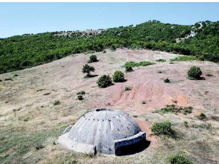
Bunker nach Norden ausgerichtet, Qafë Thana, © Alfred Diebold
